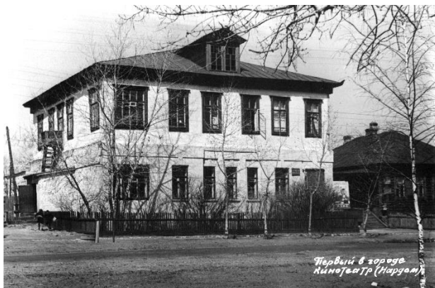
Здание аэроклуба (нардом)
